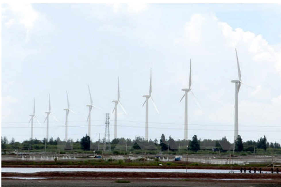
Nhà máy điện gió Bình Thuận
